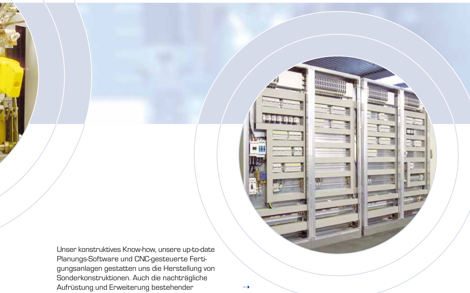
Niederspannungsgerüste für Kompaktstationen
